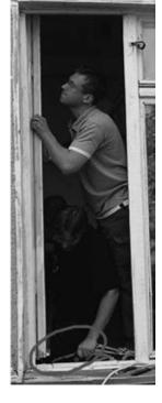
При различных конструкциях окон возможны варианты при снимании створок. Но принцип рычага остается тот же. Настоятельно рекомендуется использовать именно такой способ снимания, а не просто использование своих сил. Использование принципа рычага позволяет снять гораздо больше створок и гораздо меньше устать при этом.
